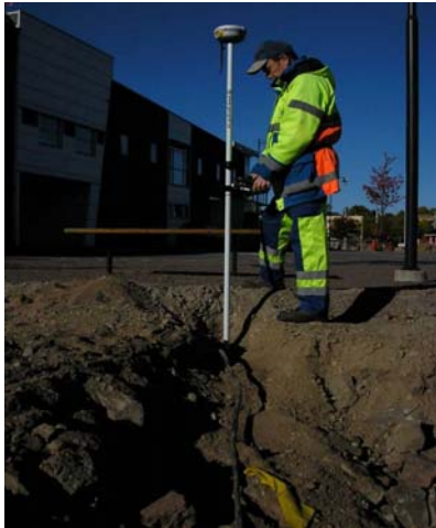
Figur 4: Inmätning av elledningar med RTK i Oskarshamn. Foto: Peter Nilsson, Oskarshamns kommun.
