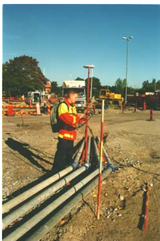
Figur 1: Kartering av ledningar genom RTK-mätning. Foto: Lasse Halvarsson.
