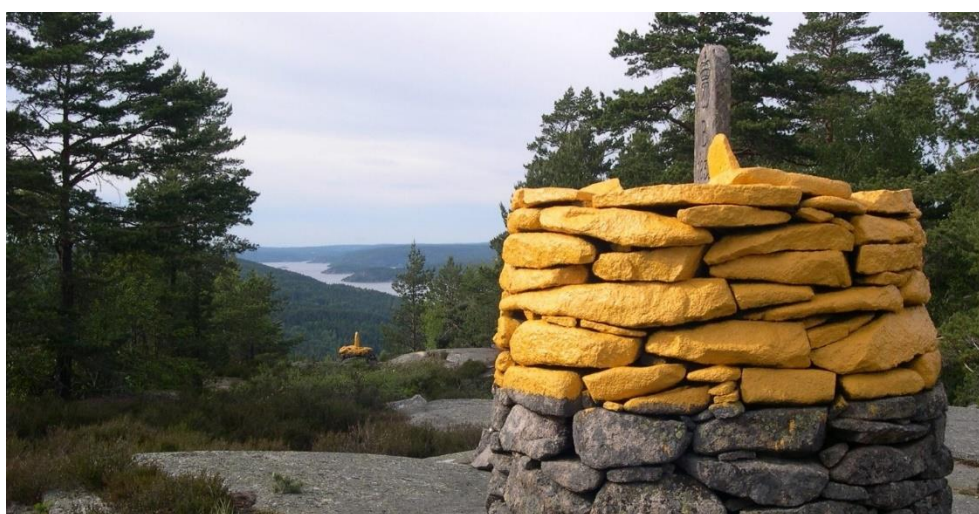
Figur 2: Restaurering av ett riksröse innebär att det görs rent, gulmålas samt vid behov staplas om och att dess hjärtsten rätas upp i vertikalt läge. Bild: Tor Erik Bakke, Kartverket.
