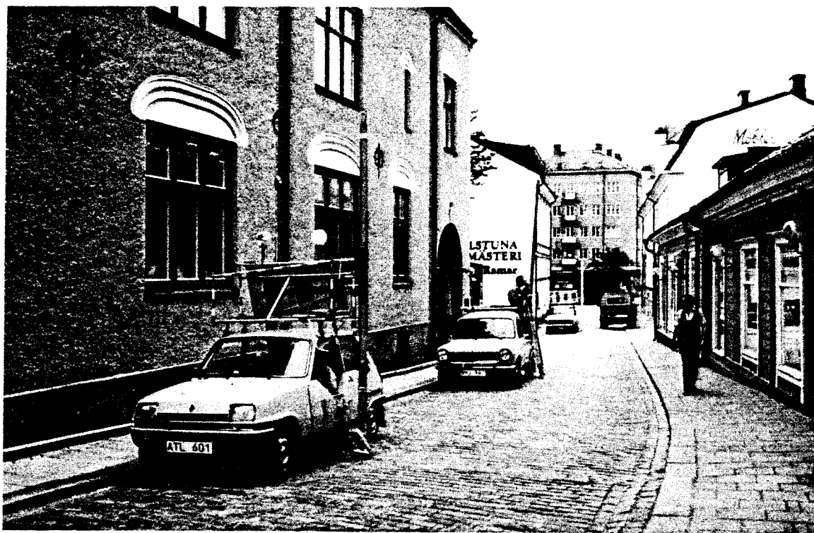
Motoriserad avvägning i stadsmiljö
