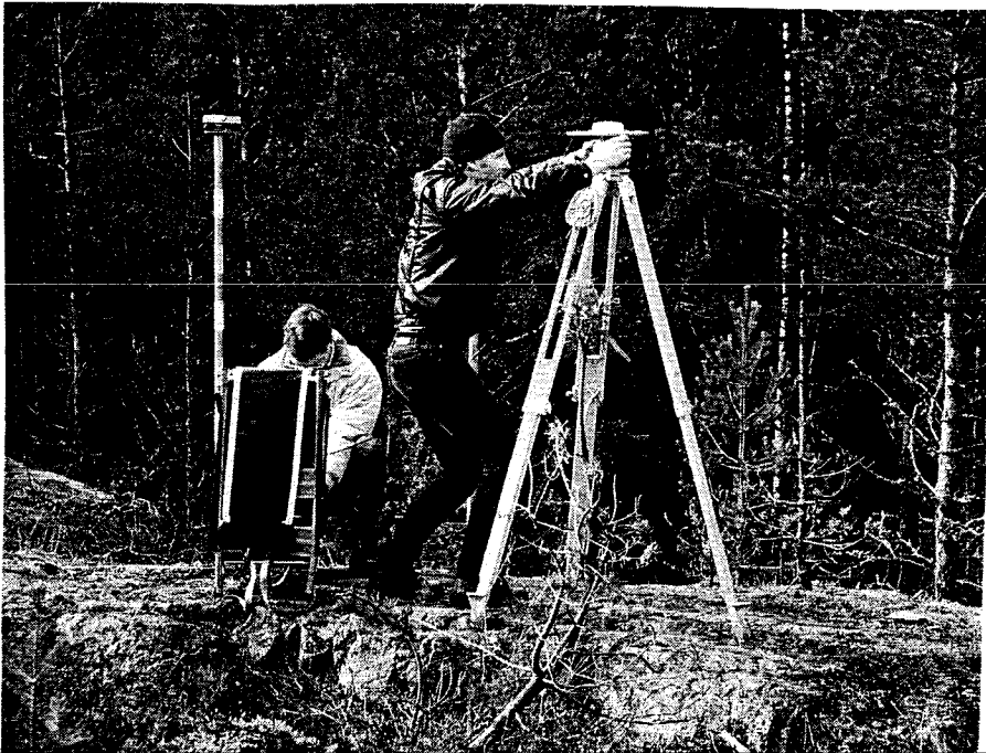
Figur 4. Stationsetablering vid ett besök.
